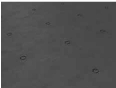
4. Segnare i punti di fissaggio sulla membrana
