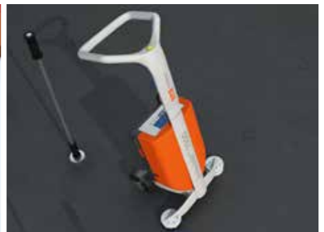
6. Saldare i punti di fissaggio alla membrana
