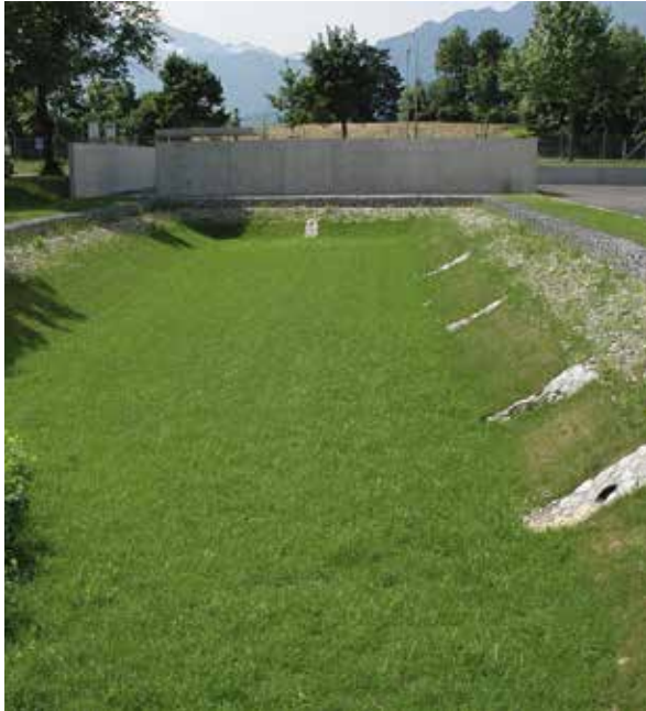
Impianto d'incenerimento di Thun: il bacino di ritenzione è stato impermeabilizzato nel giro di tre giorni dal ricevimento dell'ordine.
