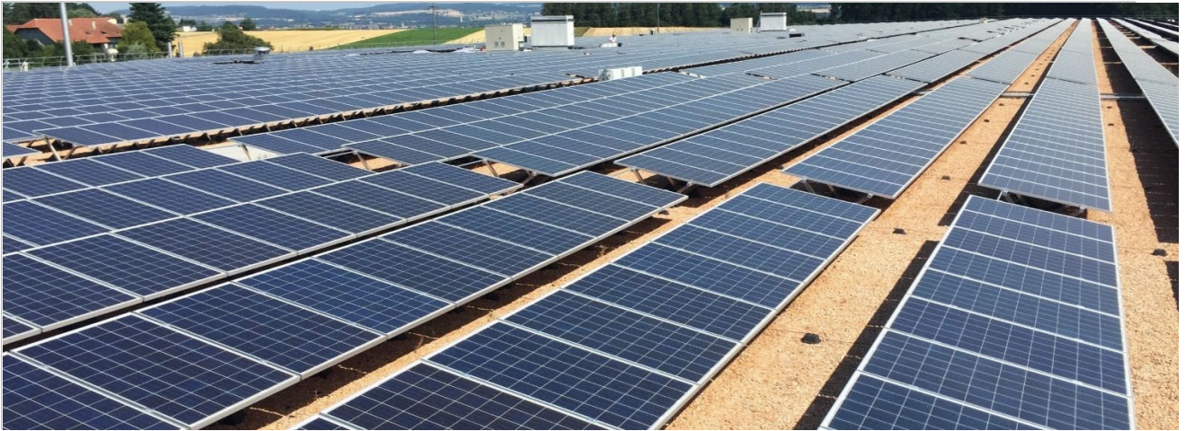
Lidl Suisse, centre de distribution, Sévaz
