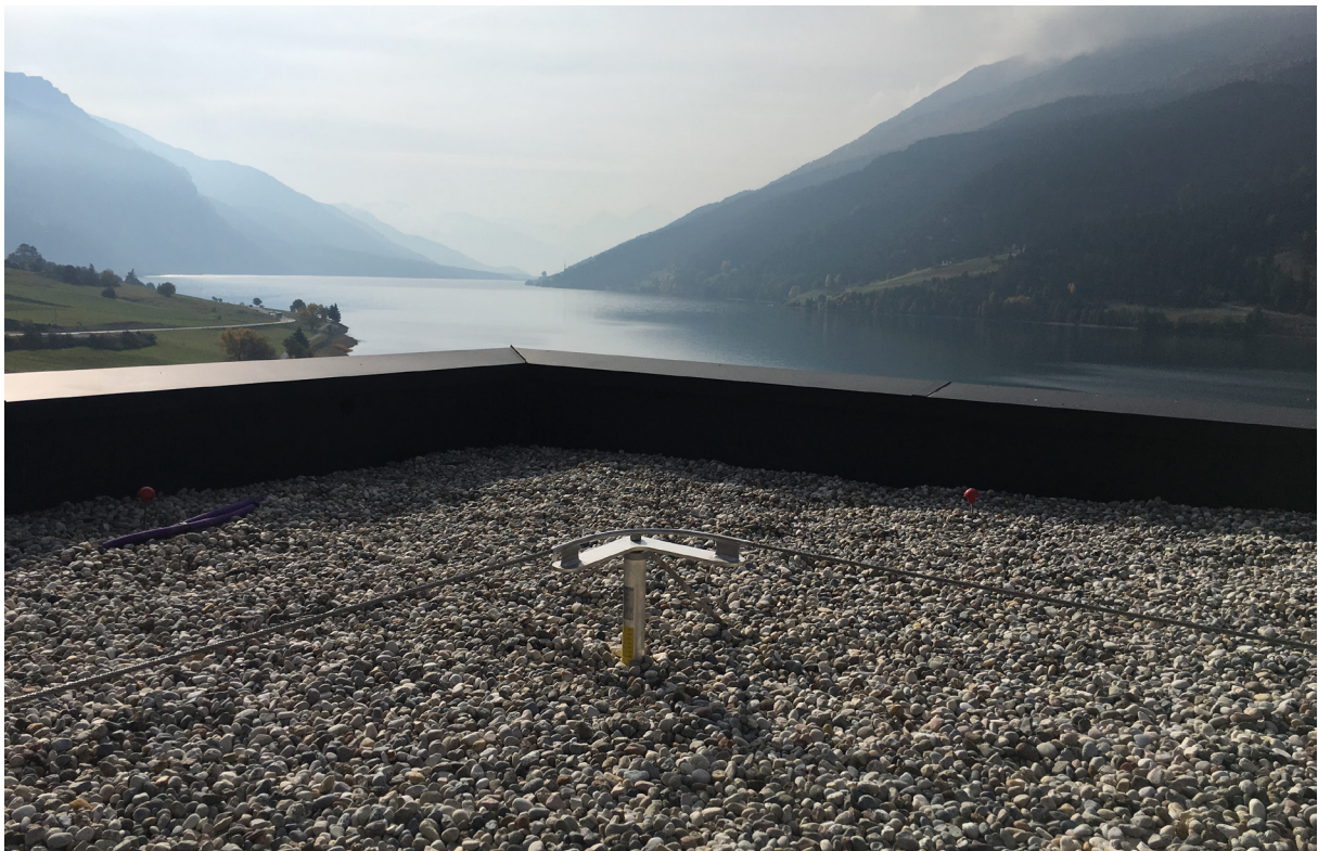
2 ans après installation
