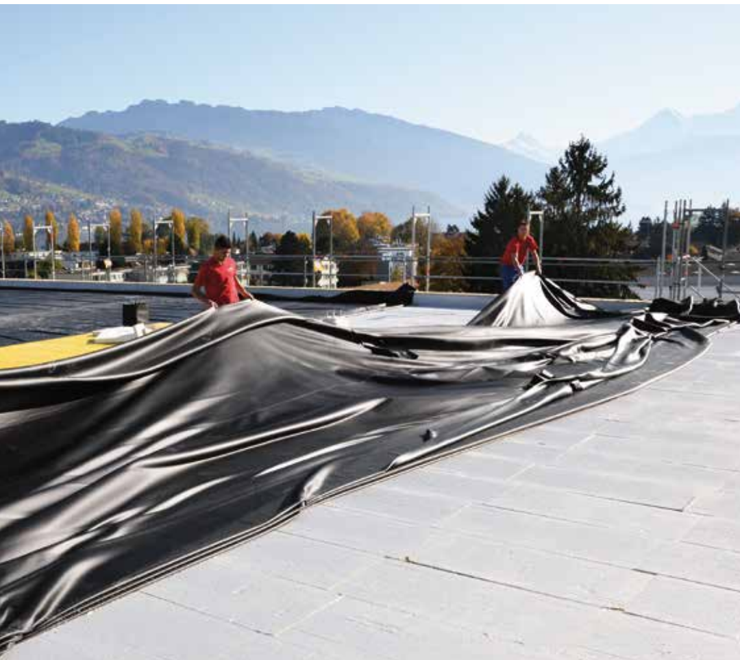
Entfalten und ausrichten
