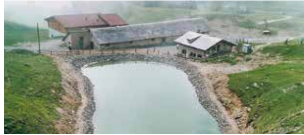
Depuis 2000, l'enneigement est assuré: le domaine skiable de Tschierl alimente ses installations d'enneigement à partir du réservoir de 2 700 m 3 situé sur le col d'Ofen.
