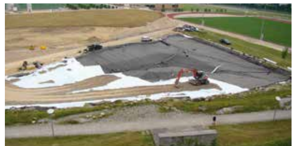
Ausrollen und ausrichten
