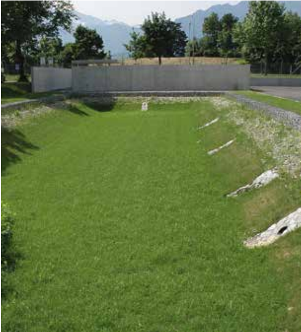
Usine d'incinération des ordures ménagères de Thoun: trois jours après avoir passé commande, l'étanchéité du bassin de rétention était assurée.
