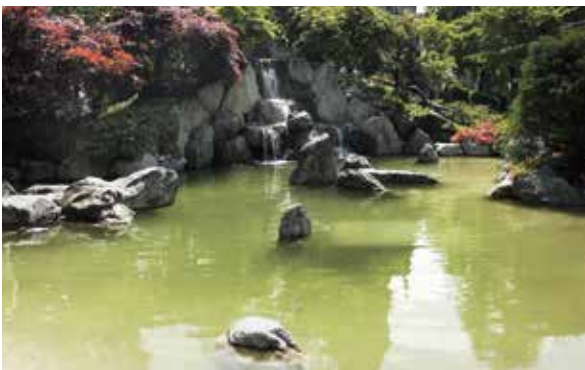
En harmonie avec la nature: l'étanchéité des biotopes même de formes complexes est assurée en un temps record grâce à la préfabrication sur mesure.
