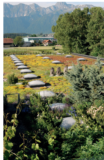
Végétalisation intensive de la toiture
