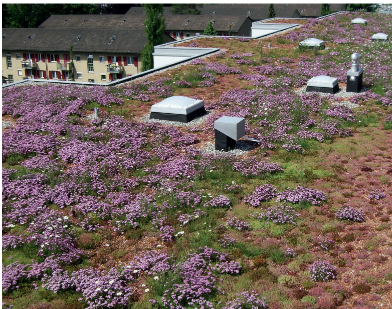
Végétalisation extensive de la toiture
