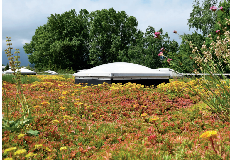
Végétalisation extensive de la toiture
