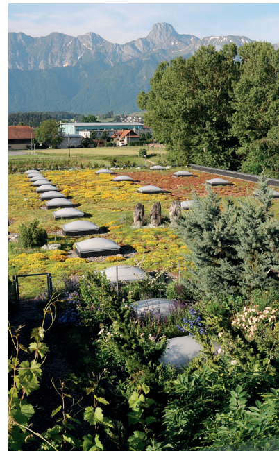
Intensive & extensive Begrünung
