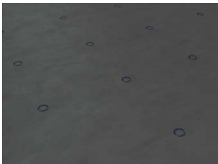
4. Befestigungspunkte auf der Dachbahn markieren
