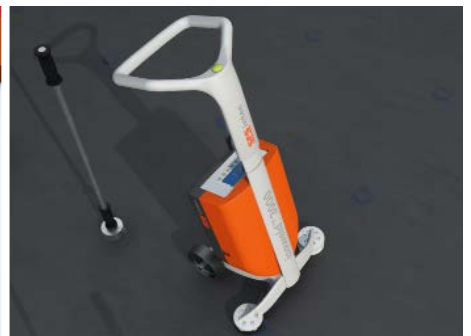
6. Befestigungspunkte mit der Dachbahn verschweißen
