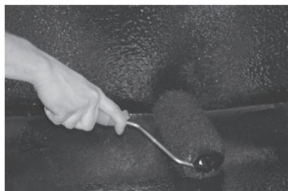
Der Untergrund muss löse-mittelbeständig, sauber, fettfrei und trocken sein. Der Klebstoffverbrauch beträgt 400 - 600 g/m<sup>2</sup> (200 - 300 g/m<sup>2</sup> je zu verklebende Seite). Die benötigte Klebermenge variiert je nach Saugfähigkeit des Untergrundes.
