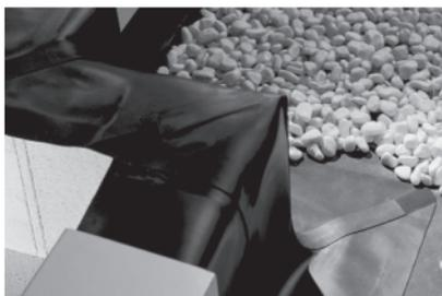
Bei loser Verlegung wird die Abdichtung gegen Windsog mit Dachbegrünung, Kies, Plattenbelägen oder Holzrosten beschwert.
