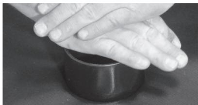
4. Klemmring und Abdichtung mit Silikonspray besprühen, Klemmring mit angefasster Seite in Steckmuffe drücken.
