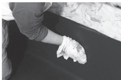
2. Aufbordnung vollflächig aufkleben, von der Mitte zur Ecke hin. Ab 60 cm Aufbordnung ist die Montage von Contec.fix empfehlenswert.
