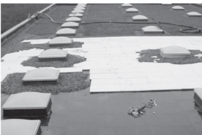
Für die jeweiligen Aufbauten werden Schutzvliese und Drainageplatten über der verlegten Abdichtung eingebaut.
