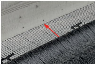
Die Abdichtung muss über die gesamte Aufbordsabwicklung sowie 20 cm in der Horizontalen, auf geeignetem Untergrund, geklebt oder mechanisch befestigt werden. Es darf nur der geprüfte Contec.adhesive Kleber verwendet werden. Wenn erforderlich, muss die Dämmung mit der Unterkonstruktion mechanisch oder chemisch verbunden werden.
