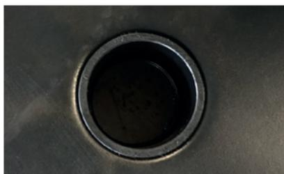
5. Der Anschluss ist fertig ausgebildet, wenn der Klemmring bis zum Anschlag eingedrückt ist. Übermäßige Faltenbildung deutet auf zu kleinen Ausschnitt hin. Korrigieren, um ungehinderten Wasserabfluss zu gewährleisten.
