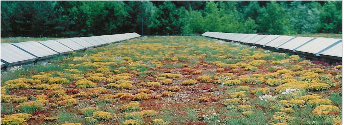
Gruppe Rüstung BAG, Zeughaus, Lager, Lager-/Einstellgebäude, Brugg
