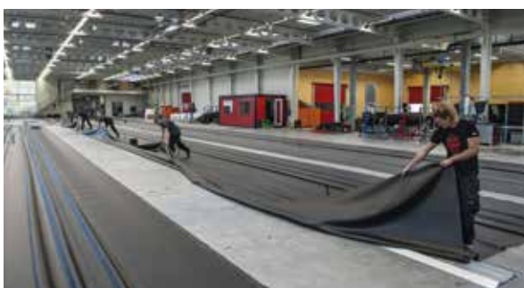
Auslegen & schweißen der Bahnensegmente
