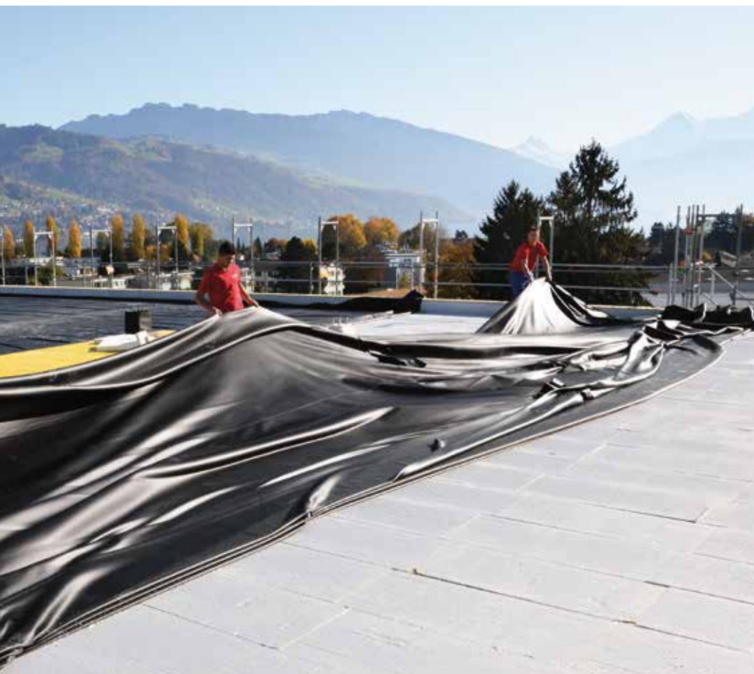
Entfalten und ausrichten
