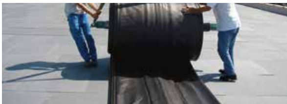
7. Punktgenaues Abrollen Die Abdichtung wird über dem im Voraus bestimmten Punkt positioniert und von dort aus abgerollt.
