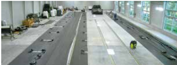
5. Bahnen zusammenschweissen Die einzelnen Contec.proof-Bahnen werden gemäss CAD-Plan zusammengesweisst.
