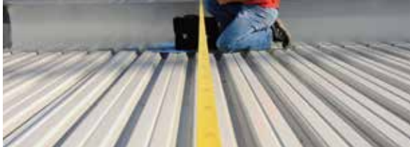
1. Mass nehmen Die Masse werden in der Regel vor Ort mit Massband oder Theodolit aufgenommen. Sie können aber auch exakten Dachplänen entnommen werden.
