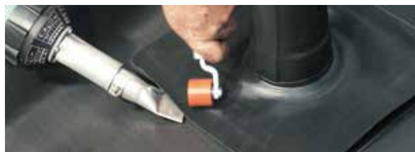
9. Letzte Details einschweissen Die mit einem Thermofast®-Fügerand versehenen Einzelteile wie Lichtkuppelmanschetten, Rohr- und Kamineinfassungen sowie Ecken werden – wenn nicht bereits in der Dachhaut integriert – werkseitig vorbereitet und mit auf die Baustelle geliefert. Das Verlegeteam kann so vor Ort die letzten Formteile in die Abdichtung einschweissen.
