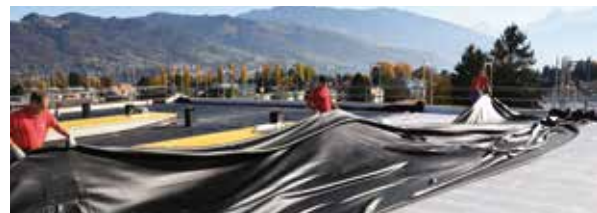
8. Ausrichten und verlegen Das Verlegeteam richtet die Dachhaut an Fixpunkten exakt aus. An- und Abschlüsse im Aufbordsbereich werden mit Contec.adhesive Kleber sauber geklebt, Entwässerungen angeschlossen, Dachranddetails fertig gestellt.
